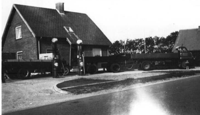
Thistedvej 337, Klim, ca. 1956. Det første Esso-benzinanlæg.
